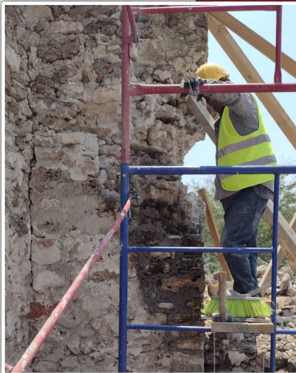
Figura 11. Apuntalamiento, reintegración de relleno y remamposteo de las esquinas contrafuerte sureste.
