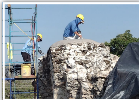
Figura 28. Colocación de corona muro norte.
