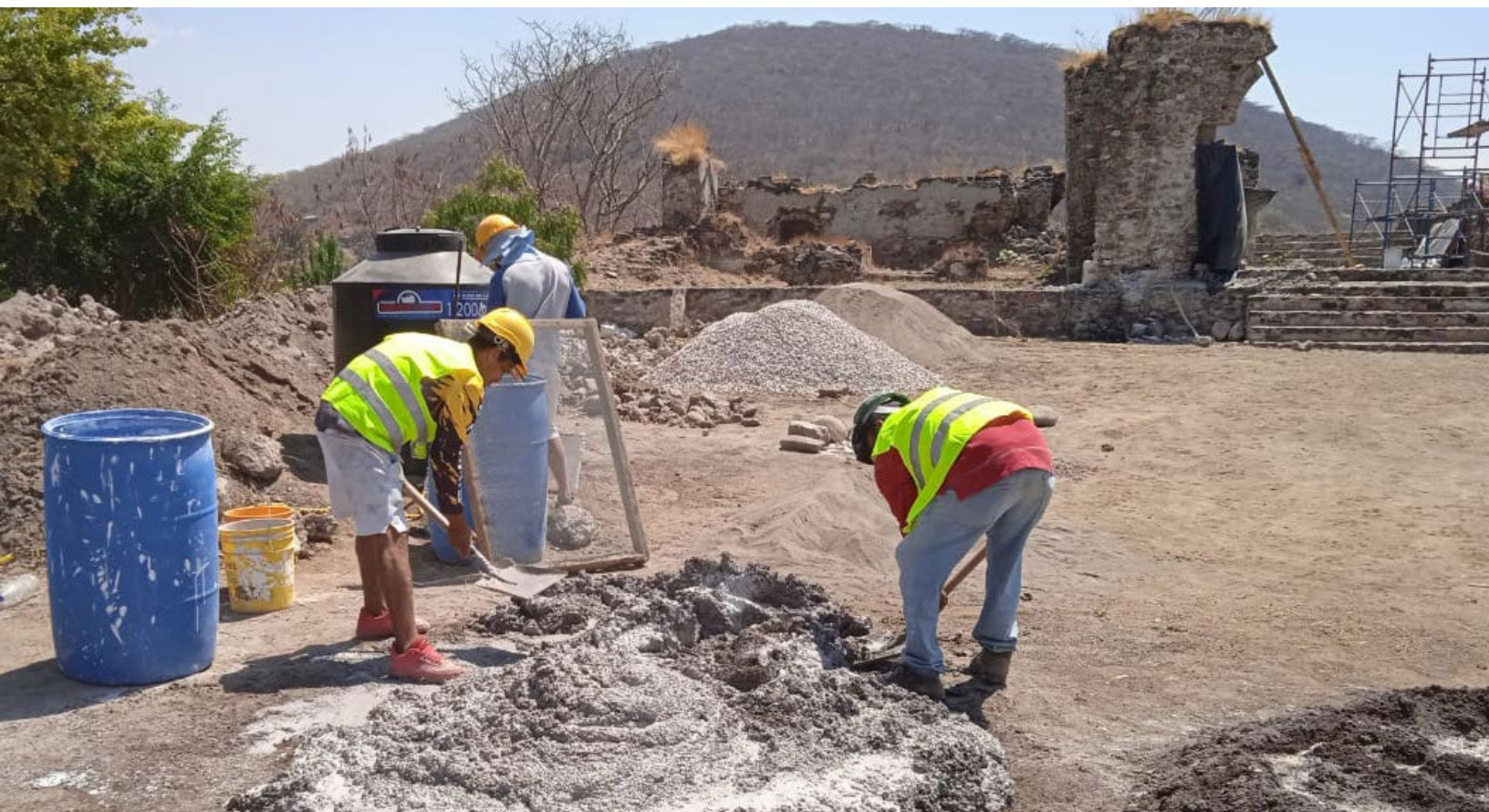
Figura 8. Preparación de la mezcla con cal, arena de tezontla y baba de nopal.
