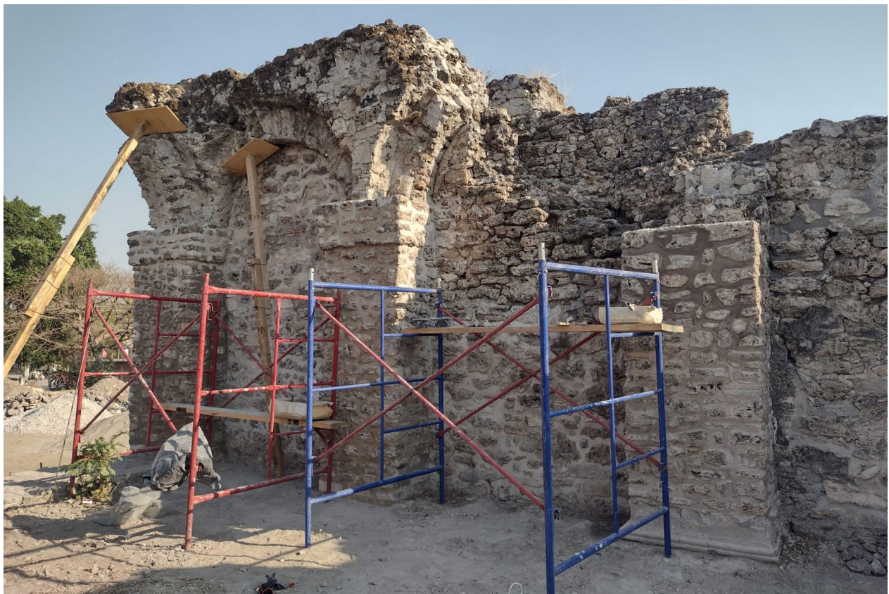
Figura 24. Mamposteo de mechinales terminados.
