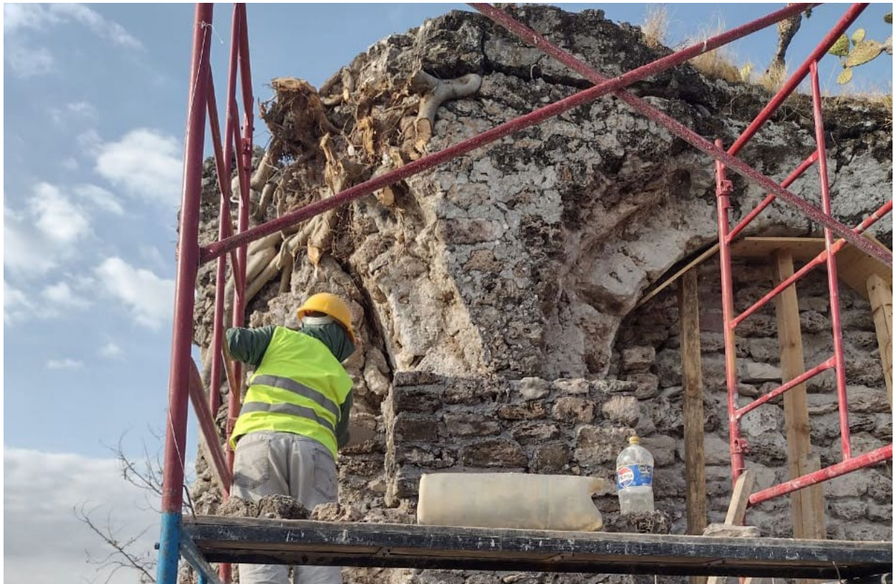
Figura 23. Mamposteo en el hueco del mechina para dar mayor apoyo al arco.
