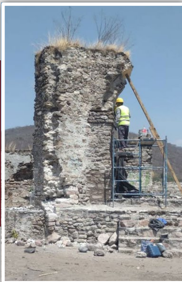
Figura 17. Contrafuerte noroeste. Inicio de restauración.
