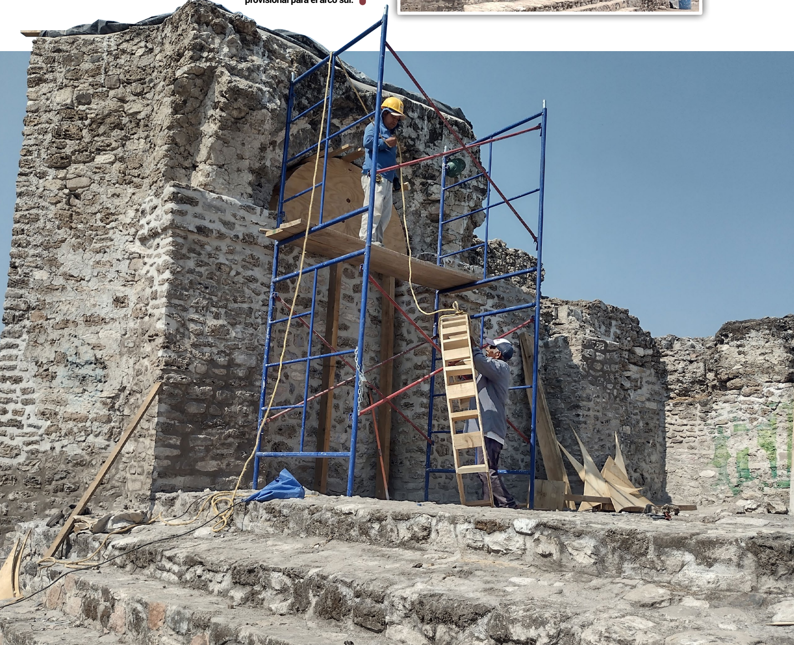
Figura 25. Cercha de madera provisional para el arco norte.
