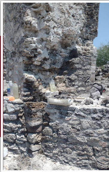
Figura 15. Detalle del remamposteo del contrafuerte suroeste.
