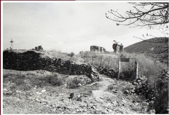
Figura 3. Estado de conservación de la capilla en 1979, foto tomada desde el suroeste (foto Wanda Tommasi).
