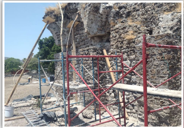
Figura 21. Pilastras muro interior norte terminadas.
