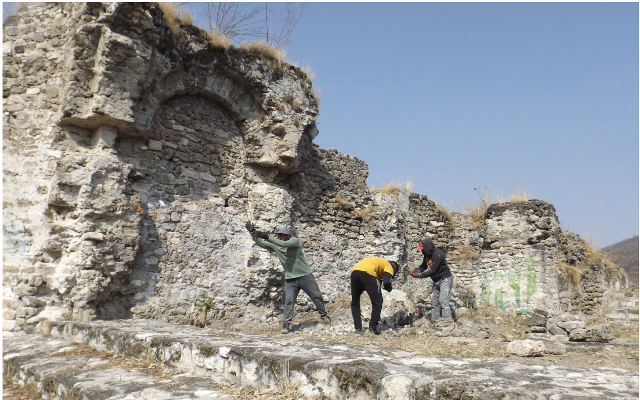
Figura 20. Interior del templo, muro norte. Pilastras, arco y mechinales.
