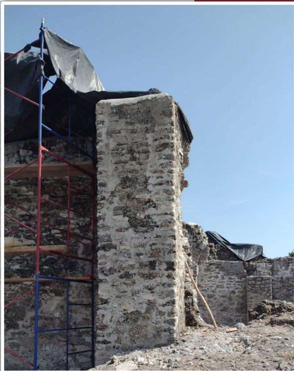
Figura 12. Final de la restauración del contrafuerte sureste.
