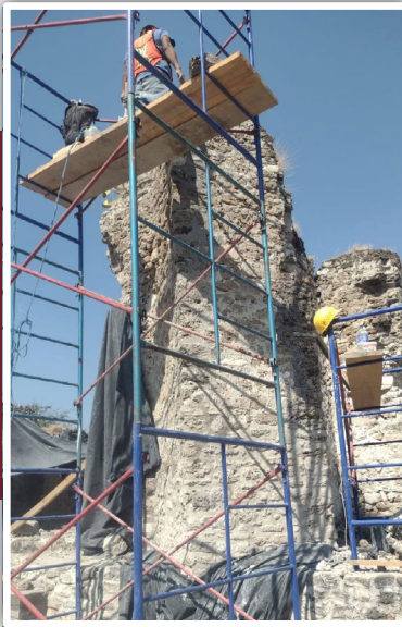
Figura 14. Remamposteo de esquinas y huecos en el contrafuerte suroeste.
