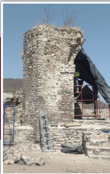
Figura 18. Contrafuerte noroeste terminado visto desde el oeste.
