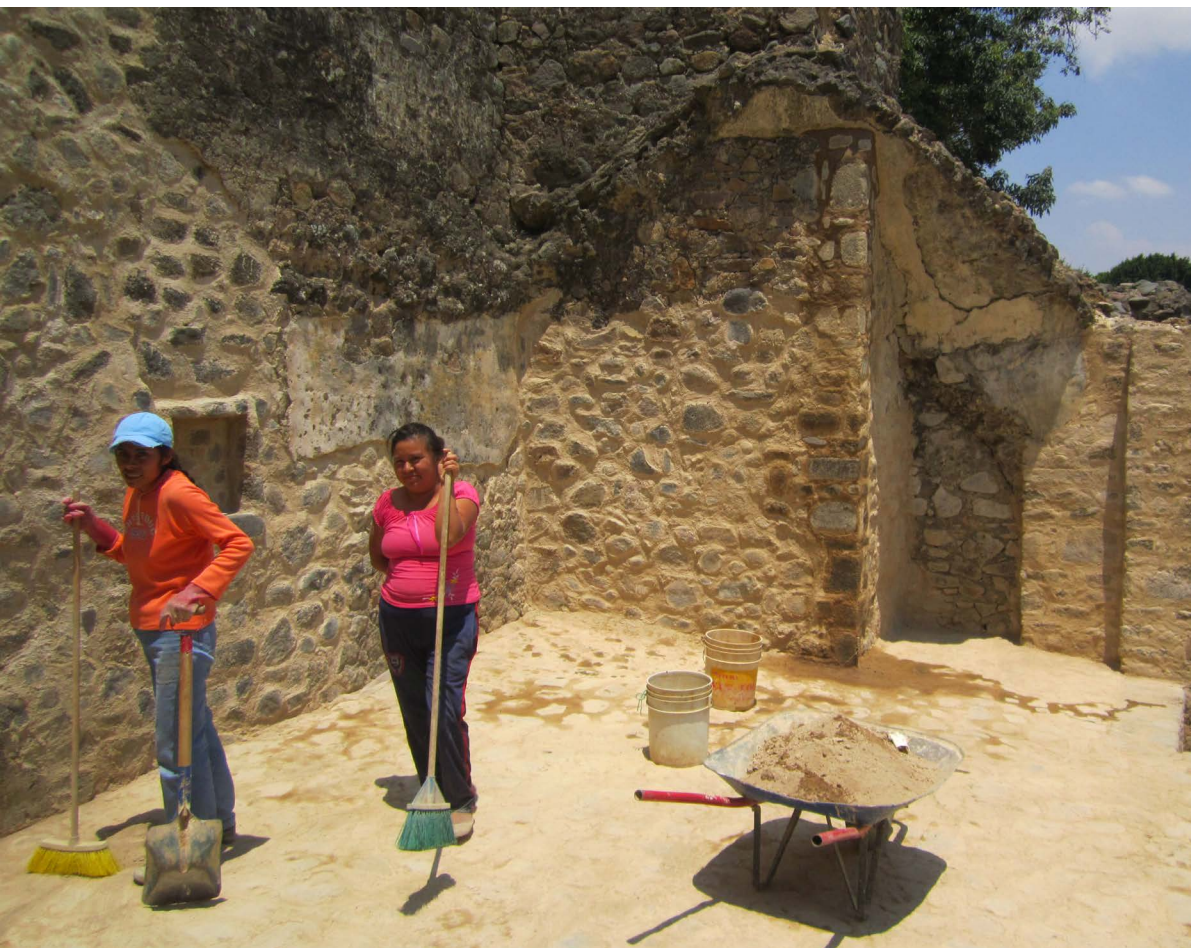
Aspecto final de la rehabilitación del espacio tras las exploraciones, con la recuperación de algunos volúmenes para sostén estructural, recuperación de juntas perdidas. Se puede observar la proyección del contrafuerte que terminó destruyendo la capilla con el altar, y aún así, se advierte, pues parte de la bóveda con forma piramidal no fue retirada (Fotografía RFGQ 2012).
