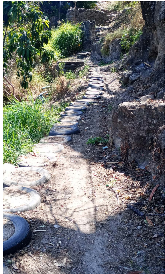
Ejemplo del uso de neumáticos para generar corazas de terrazas que sirven para los caminos internos en las barrancas de muchas partes semi urbanizadas del Glacis de Buenavista (Fondo PICZAT 2025).
