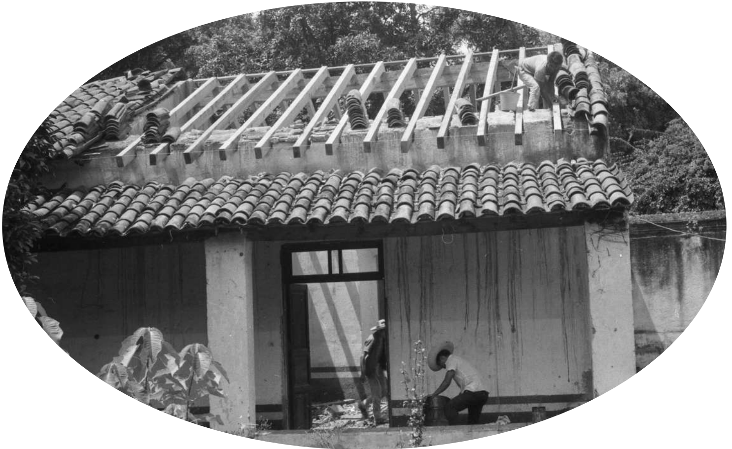
Trabajos de rehabilitación en la Villa "El Olindo" para albergar las oficinas del Centro Regional INAH Morelos-Guerrero. Acapantzingo, Cuernavaca, Morelos, México, octubre de 1969. Fototeca "Juan Dubernard". Centro INAH Morelos.
