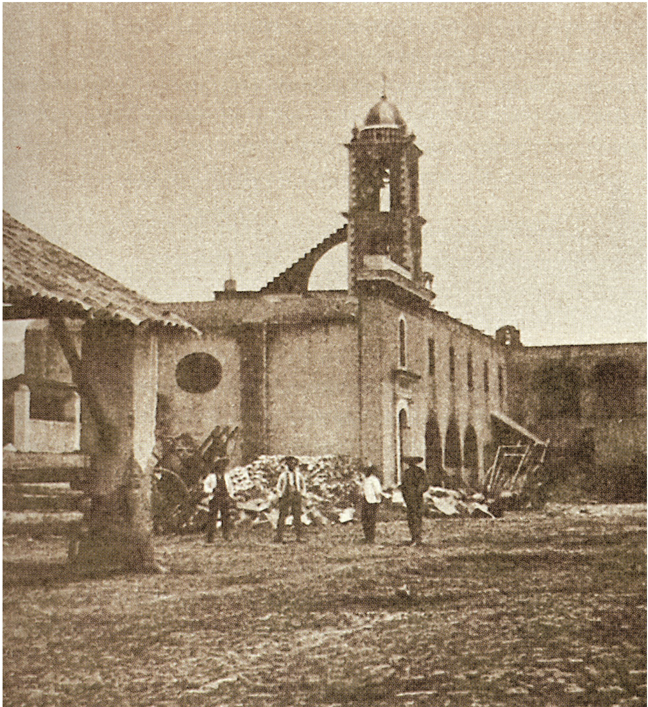
Von Mentz, Brígida, Conjunto de la ex hacienda El Hospital, visto desde el Batey, 1888, fotografía de Visión general de la historia de las haciendas , p. 43.
