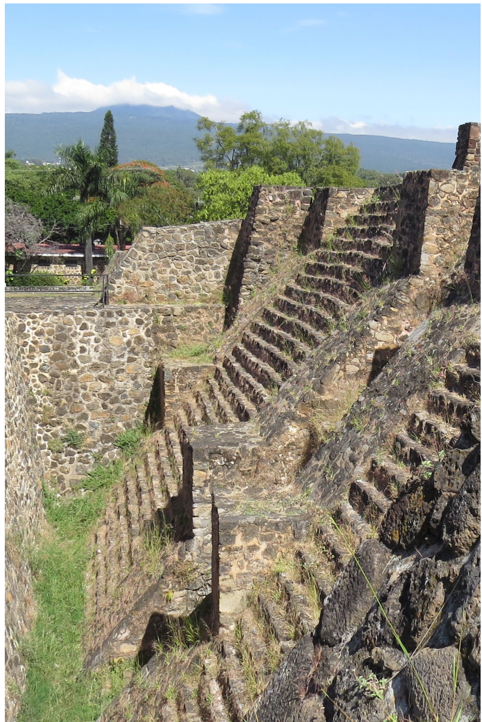
Fig. 3. Foso oeste del Gran Basamento de Teopanzolco. Fotografía: Barbara Konieczna.
