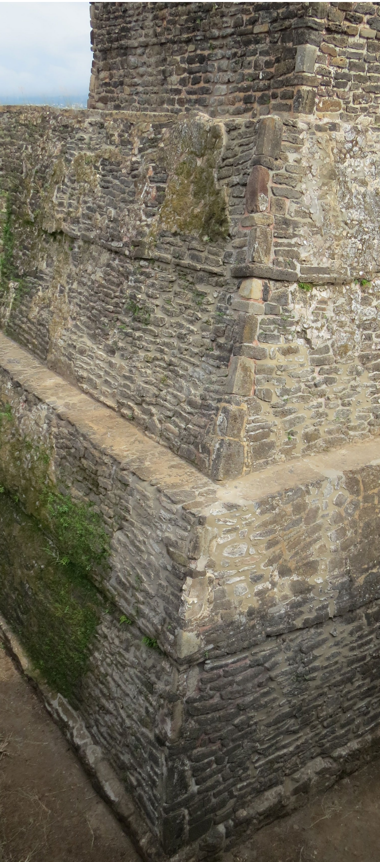
Fig. 6. Esquina sureste de la Subestructura del Gran Basamento. Fotografía: Barbara Konieczna.
