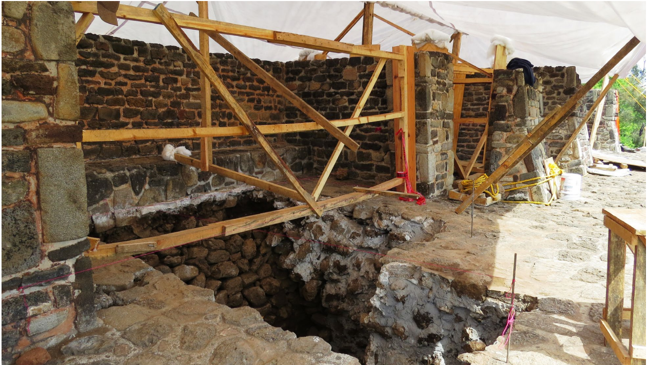
Fig. 10. Excavación al interior de la Subestructura, 2018. Foto Georgia Bravo Lopez.
