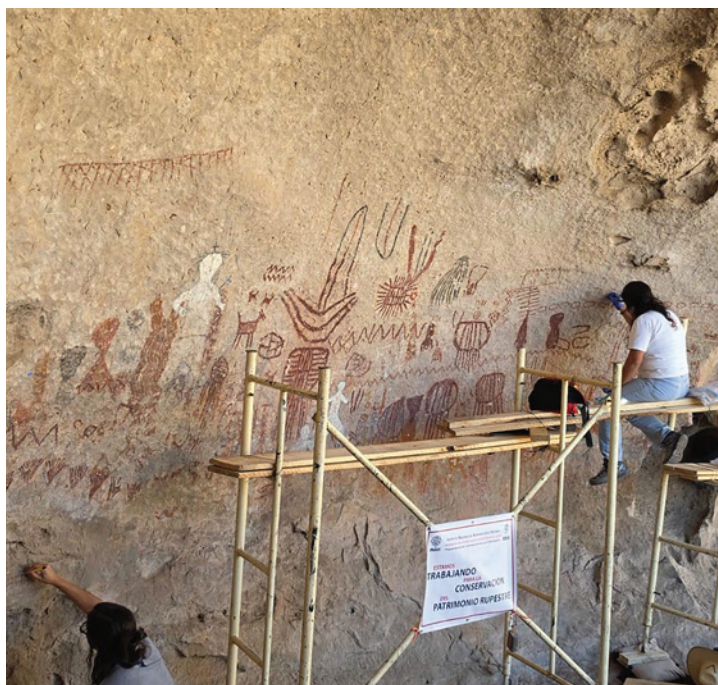
Trabajos de restauración en el abrigo principal de Cueva de las Monas, Chihuahua, 2026. Fotografías: PNCPGR-CNCPC.
