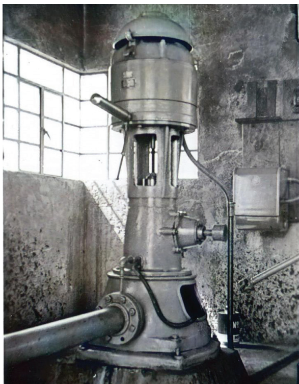
Motor eléctrico y bomba del pozo. Nuevo Casas Grandes, Chihuahua, 1949. Fotografía: Junta Federal de Agua Potable.
