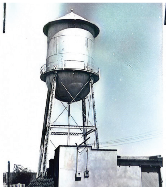
Tanque metálico elevado. Nuevo Casas Grandes, Chihuahua, 1949. Fotografía: Junta Federal de Agua Potable.
