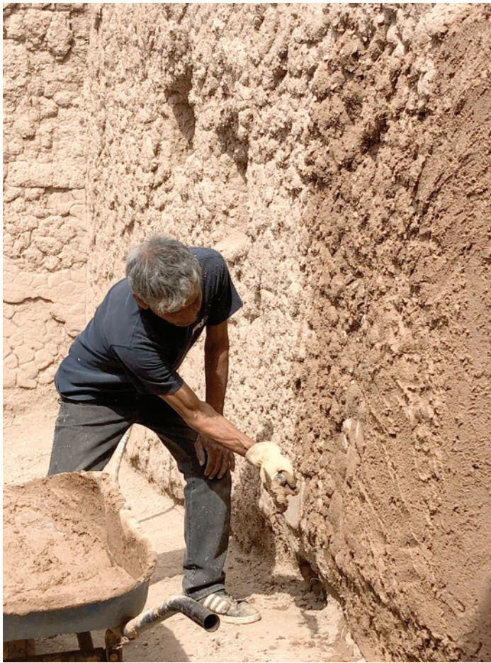
Trabajador empleando enjarre de sacrificio en muro de Zona Arqueológica de Paquimé, Casas Grandes, 2008. Fotografía: Centro INAH Chihuahua.
