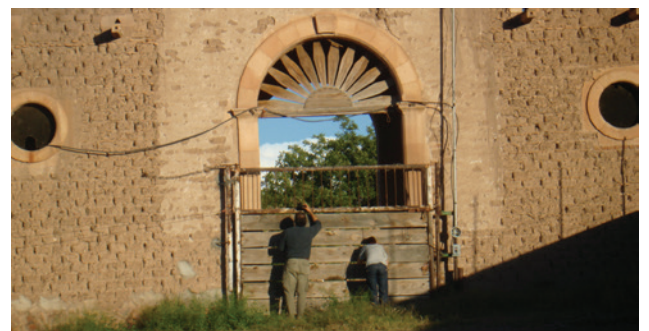
Estructura de adobe, Casas Grandes Chihuahua, 2008. Fotografía: Centro INAH Chihuahua.
