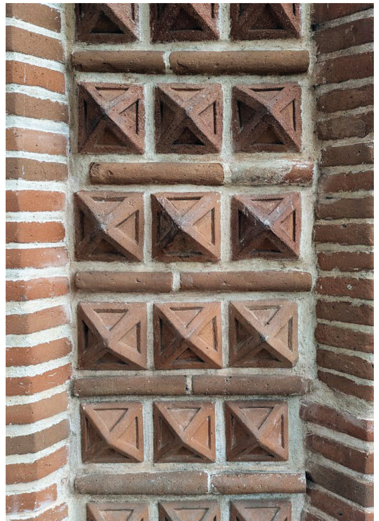
Ladrillo junteado con mortero de cal y arena. Fuente mudéjar "La Pila" en Chiapa de Corzo, Chiapas. Construido en 1562. Fotografía: Karen Zaragoza 2025.
