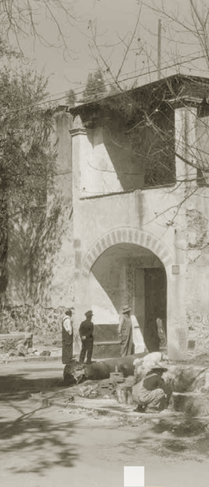
Antiguo convento de los franciscanos (detalle)
